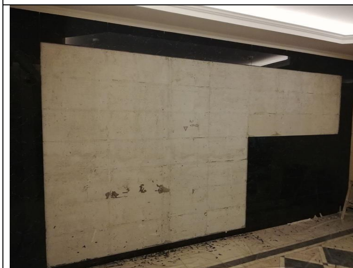
Кор.5, Сек.1, эт.11 Лифтовой холл Восстановление настенного плиточного покрытия - установка плитки затирка швов
