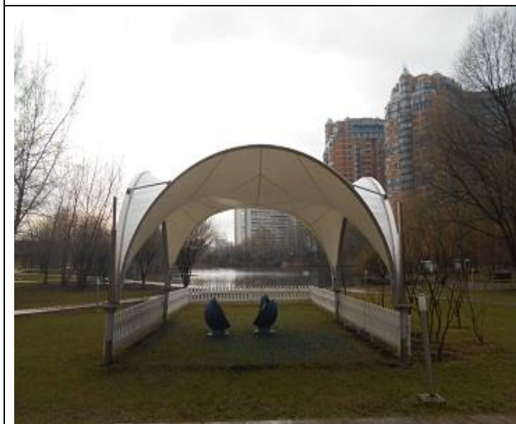
Кор.2, Территория Установка шатра -Разборка и демонтаж шатра
